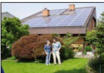
kombinierte solare Strom- und Warmwasseranlage
